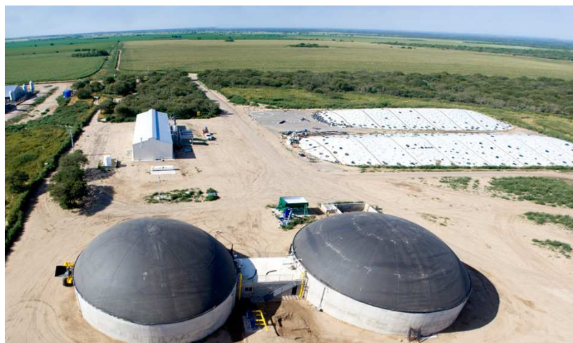
Figura 1. Planta de biogás de Yanquetruz (GESTAR COOP, 2016).
