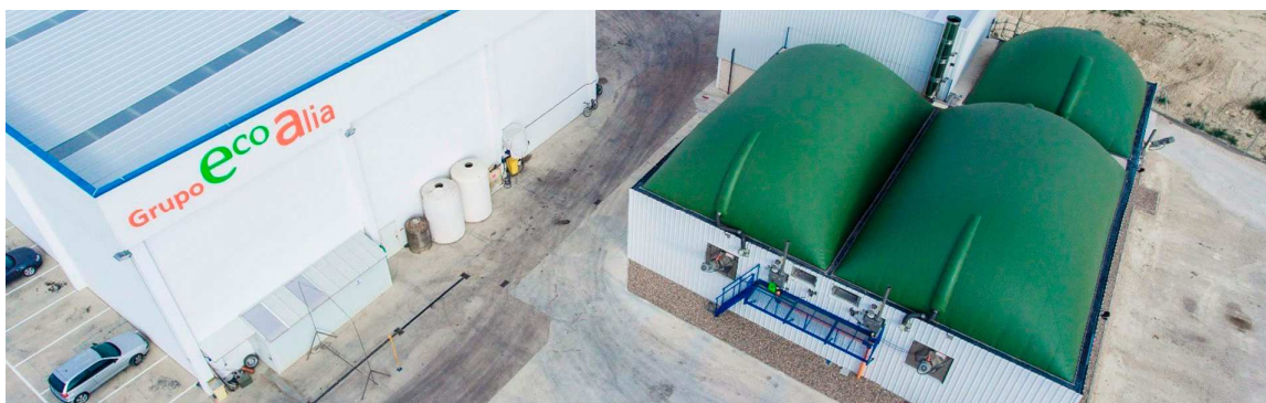
Figura 2. Planta de generación de biogás Biogasnalía (Grupo Ecoalia).
