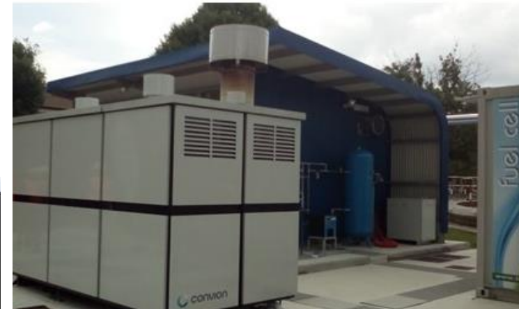
Demo SOFC 3x64kW biogas –Planta tratamiento liq. cloacales. Turin
