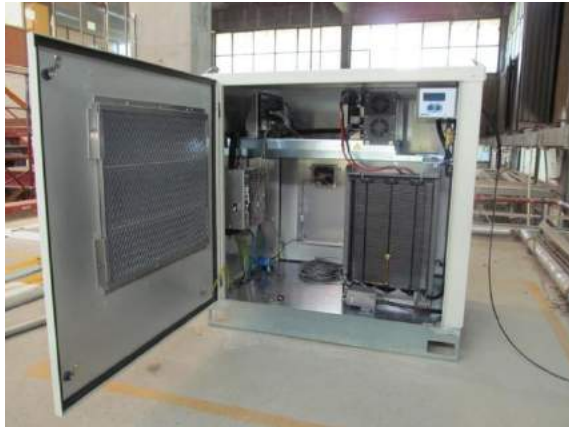
Celda de combustible PEM de 2,5 kW:
